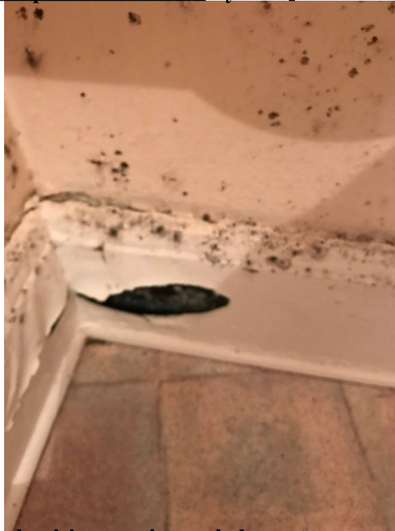
Photo n°5 : plafond cuisine au niveau de la porte : mycoses et condensation
