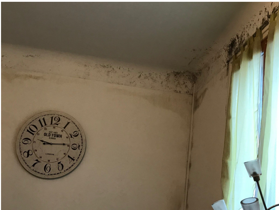
Photo n°11 : mur chambre: mycoses en haut de mur
