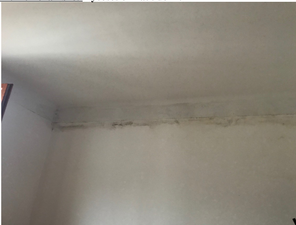
Photo n°11 : mur chambre: mycoses en haut de mur
