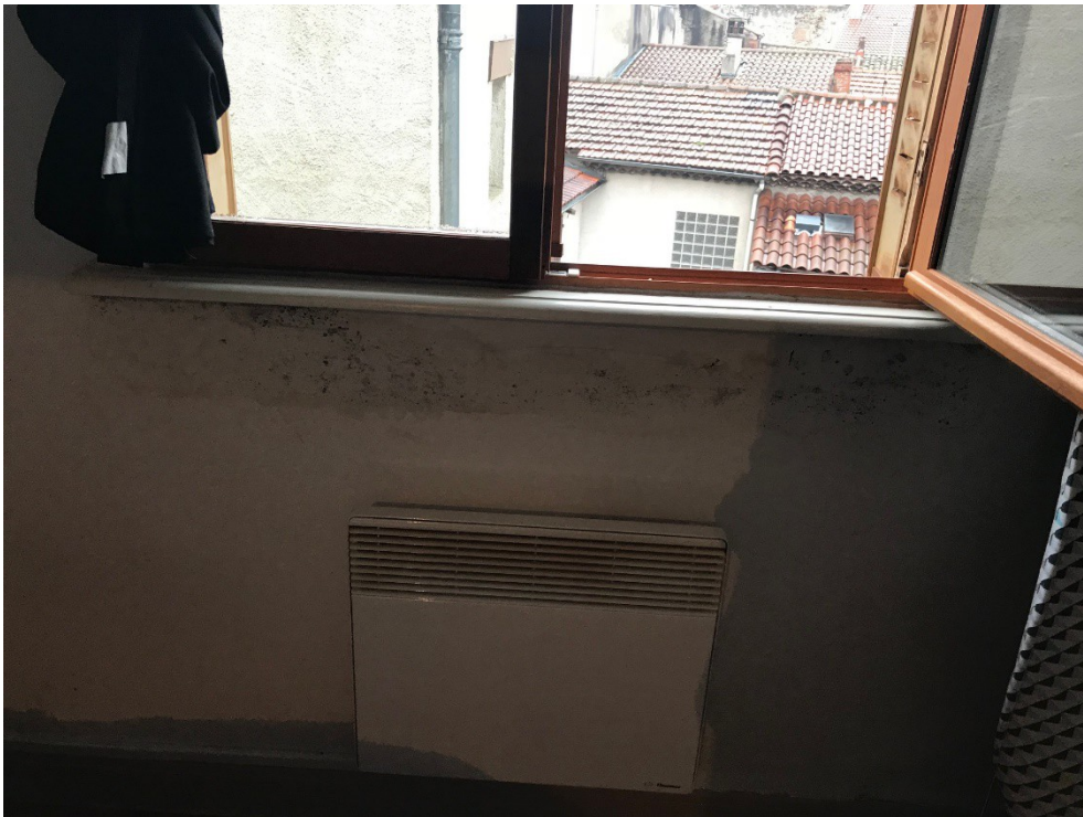
Photo n°13 : fenêtre chambre: mycoses
