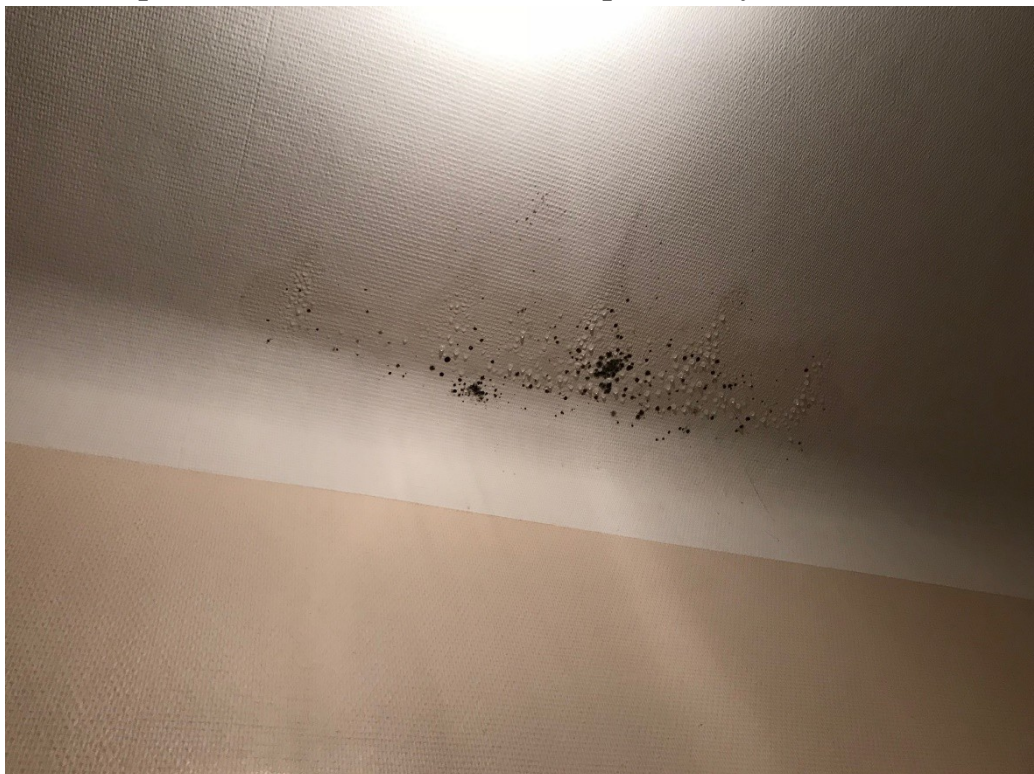
Photo n°5 : plafond cuisine au niveau de la porte : mycoses et condensation
